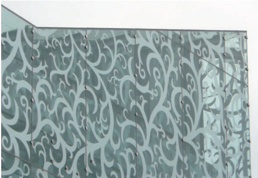
为了获得精准而持久的印刷效果，印刷该玻璃幕墙图案使用SEFAR GLASSLINE 68/175-55W 网纱。
